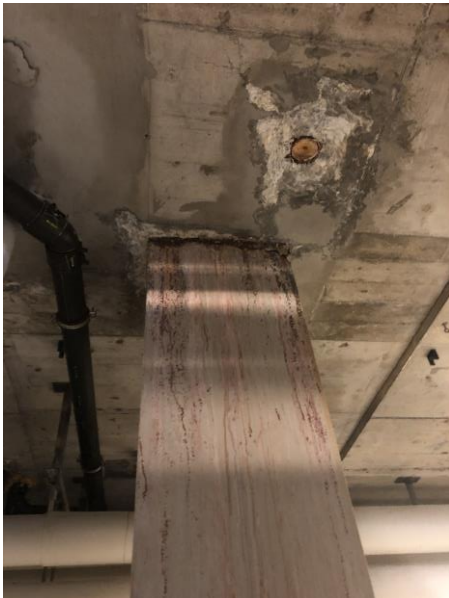
Bild 95 Deckendurchdringung der Stützen der Schwimm- und Sprunghalle (a) und Lehrschwimbeckens (b)
