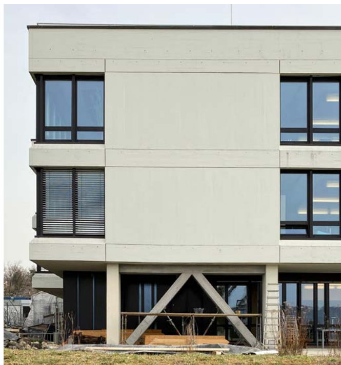
Das Schulhaus Buechholz wurde erdbebensicher gemacht.
